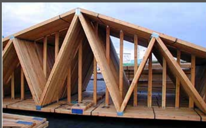
Fermes de toit avec connecteurs métalliques
